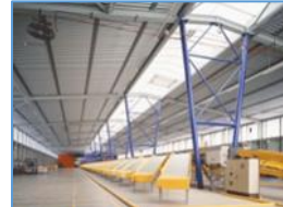
2000 Logistiek centrum montage 2.000m2 per dag
